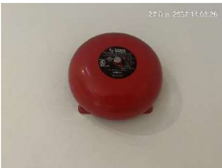
รูปที่ 29 อุปกรณ์ส่งสัญญาณแจ้งเหตุอัคคีภัย
