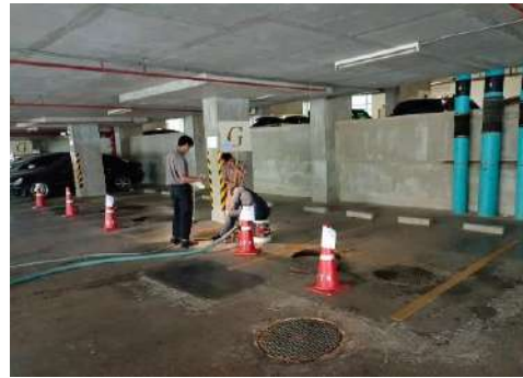
รูปที่ 49 การสูบน้ำออกจากกระบบบำบัดน้ำเสีย
